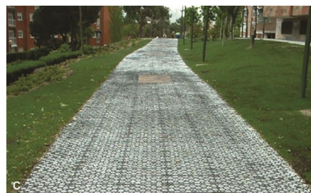
Exempel på a: "rain garden", öppen dagvattenhantering; b: sedumtak som har viss fördröjande effekt på dagvatten; c: markarmering som minskar behovet av hårdgjorda ytor
