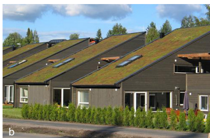
Exempel på a: "rain garden", öppen dagvattenhantering; b: sedumtak som har viss fördröjande effekt på dagvatten; c: markarmering som minskar behovet av hårdgjorda ytor
